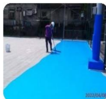
南側排球場施工中
